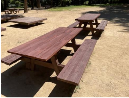
テーブル・ベンチ補修
