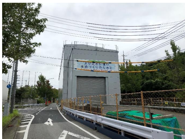
【シールドマシン発進基地】
