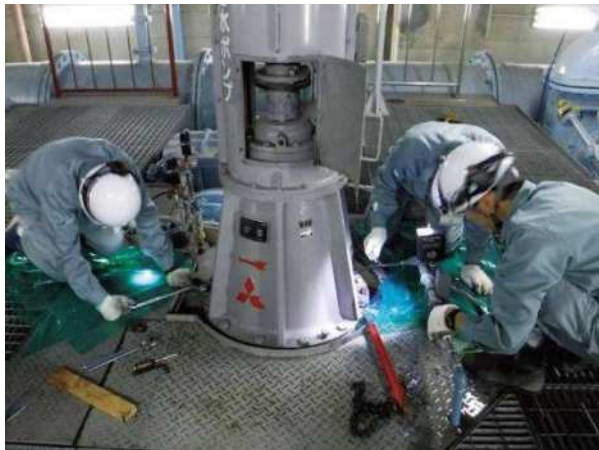
設備の補修・修繕作業
