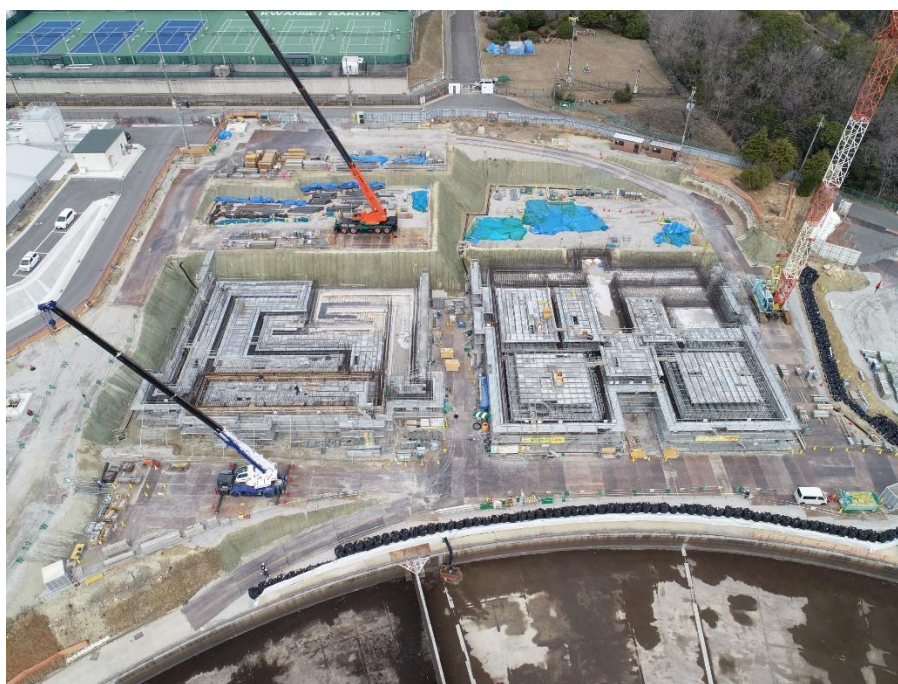
【建設状況】（令和 6 年 3 月現在）
