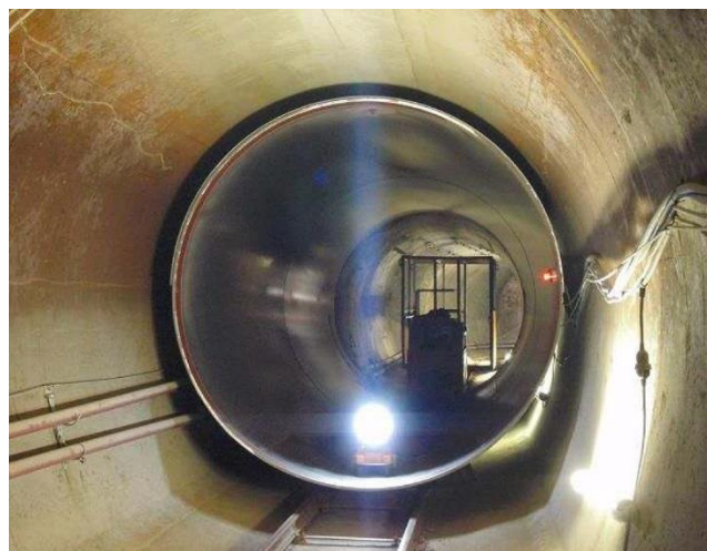
【更生工事の事例（鋼管挿入）】
