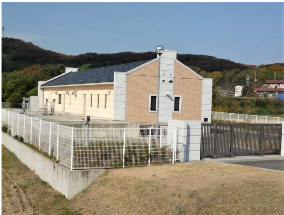
農業集落排水処理施設（中山・野瀬地区）
