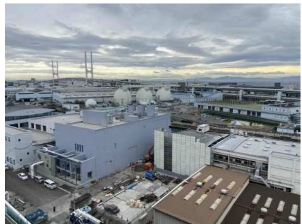
魚崎ポンプ場改築更新事業（第 1 期）
