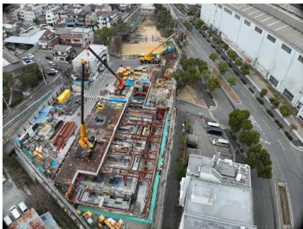
新東川崎ポンプ場整備
