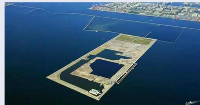
〔神戸沖埋立処分場〕
