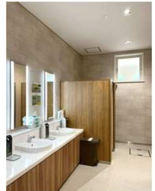
写真：トイレ照明器具LED化
