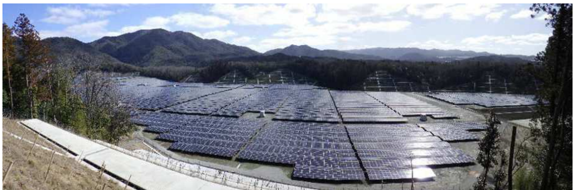
写真 1.11-1 供用後の太陽光発電施設の状況（令和 6 年 3 月 27 日撮影）
