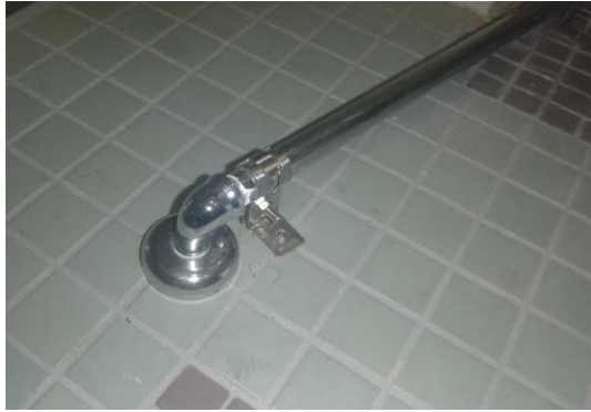
タイルの色、大きさ違い
