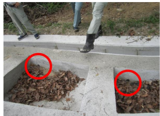
水抜きパイプの入口
