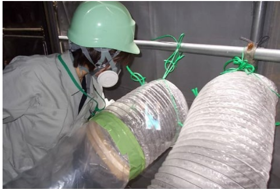
アスベストの測定
