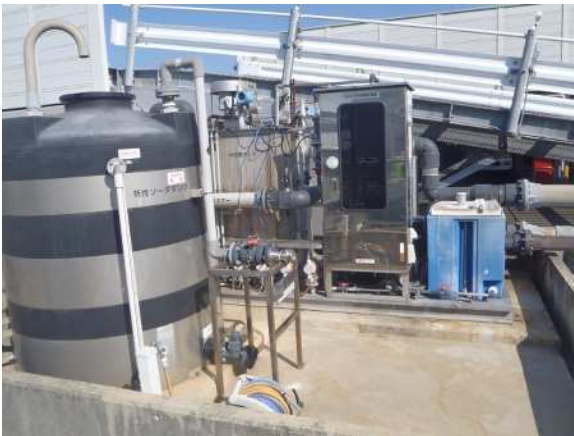
中和処理施設全体
