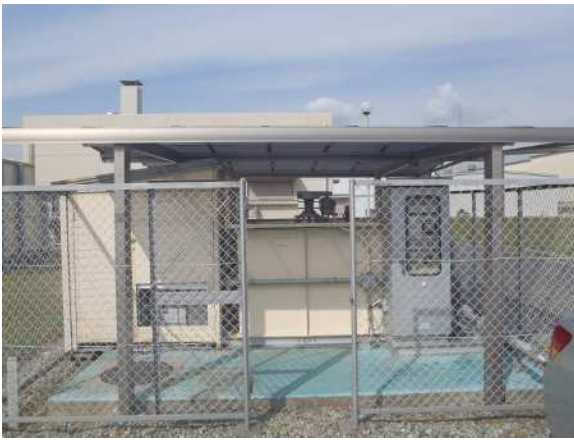
中和処理施設全体
