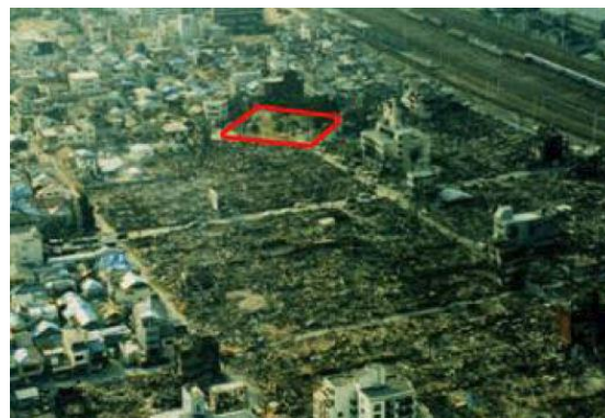
火災の焼け止まり（大国公園）
