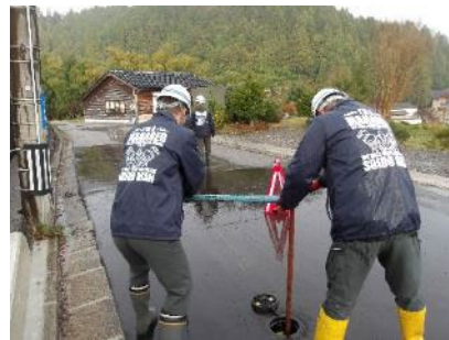
復旧工事に伴う水栓作業
