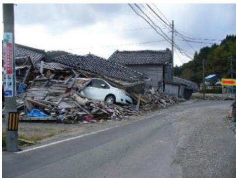
地震による建物被害
