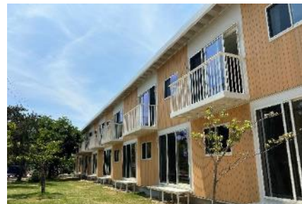
応急仮設住宅（木造型）
