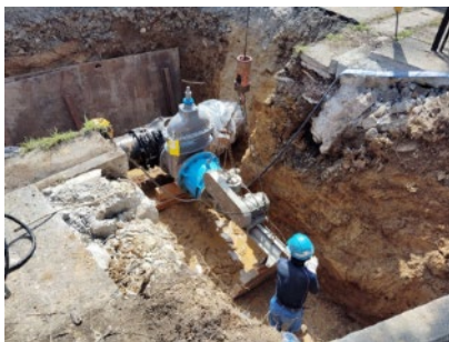
復旧工事状況
