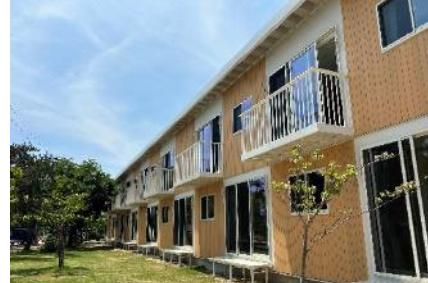
応急仮設住宅 (木造型)
