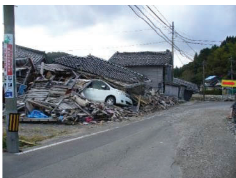
地震による建物被害
