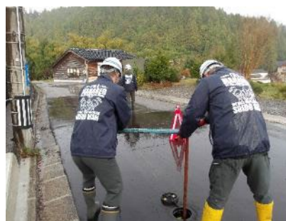
復旧工事に伴う水栓作業
