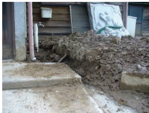
検針困難の状況
