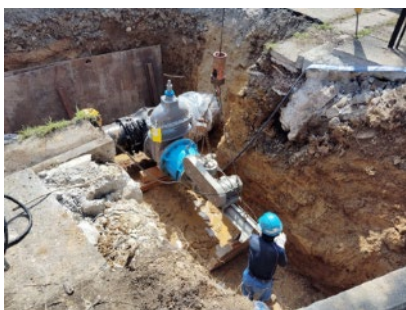
復旧工事状況
