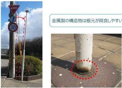
金属製の構造物は根元が腐食しやすいので、注意して点検してください。
