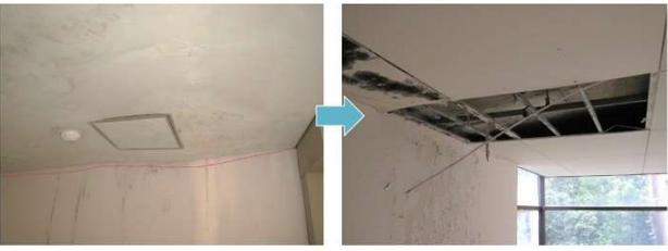
腐食により天井がたわんでいます。 腐食が進むと落下につながります。
