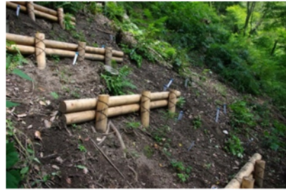
土留めの設置状況
