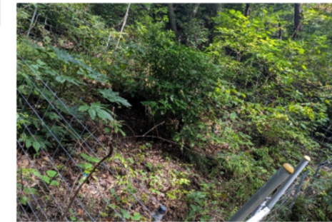
柵内（奥側に土留め設置）
