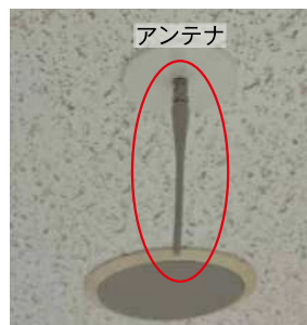
《図2》天井下方向の設置例
