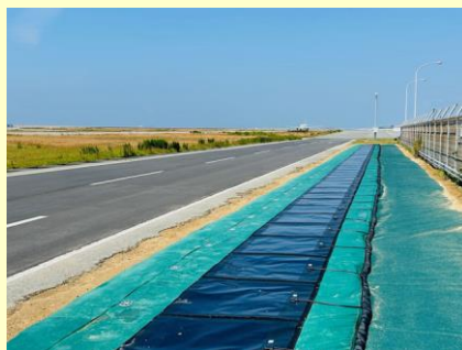
図 19 神戸空港制限区域内緑地帯への設置
