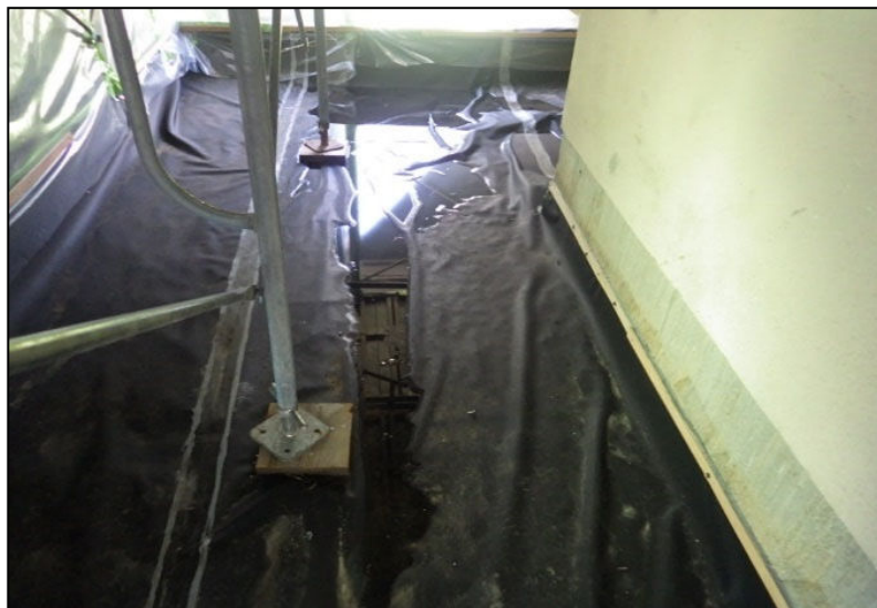
③ 石綿回収ピットイメージ写真
