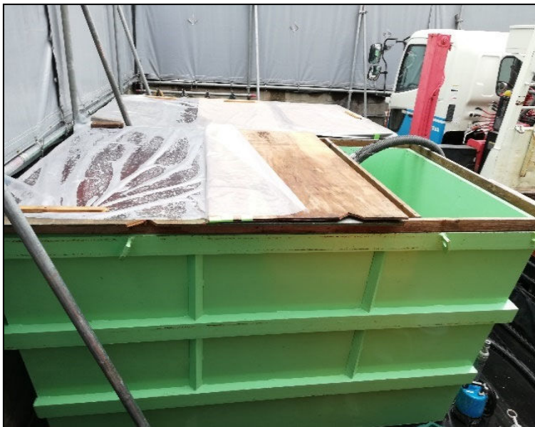
③ 石綿回収ピットイメージ写真
