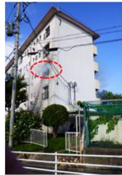
出火建物北面の状況
