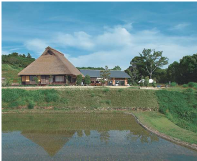
茅葺民家の保全活用
