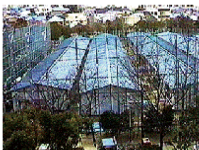
建設が進む仮設住宅
