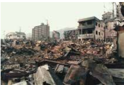
焼失した建物<灘区>
