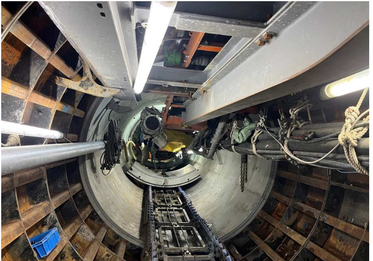
②雨水幹線（シールドマシンで掘進中です。JR 高架橋を越えた所まで進んでいます。）
