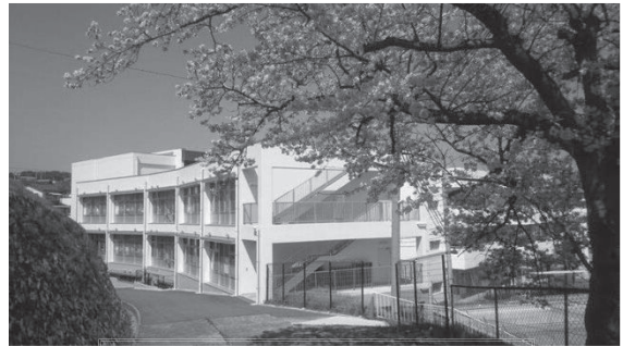
小学部棟 平成 26 年 3 月完成
