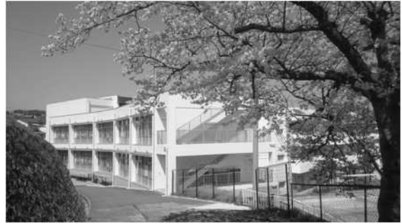
小学部棟 平成 26 年 3 月完成
