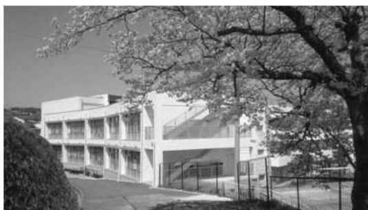
小学部棟 平成26年3月完成
