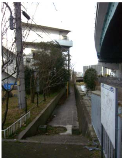
現況写真⑦
