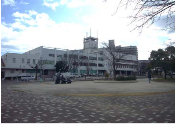
現況写真①
