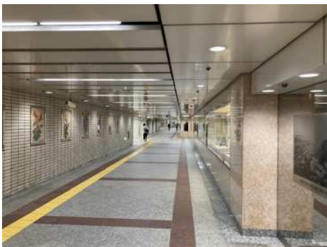
地下通路（現状）写真
