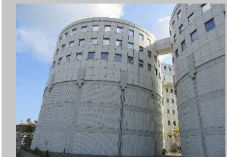
■汚泥消化タンク Sludge digestion tanks 汚泥中の有機物を嫌気性微生物の働きで消化ガスと水に分解し、汚泥の量を少なくするとともに汚泥を安定化させます。
