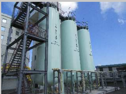
■ガスホルダ Gas holders ガス発電や給湯ボイラに使用する精製ガスを貯蔵します。
