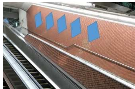
▲新長田駅サイネージ設置予定箇所
