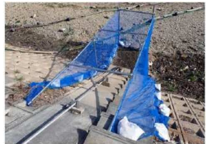
取水施設周りに防風ネットを設置
