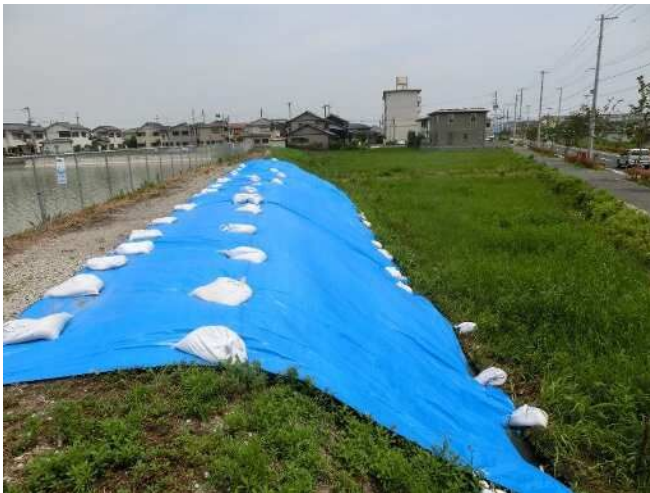
堤体下流法面にブルーシート設置
