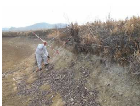
堤体の浸食状況等の点検
