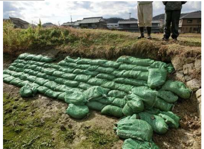
堤体上流法面に土のう設置
