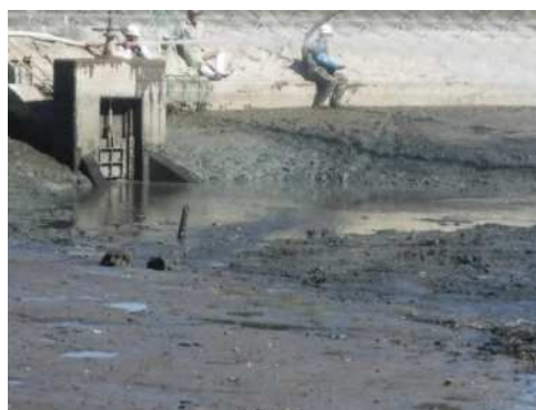
泥土除去後の状況(かいぼり実施後)
