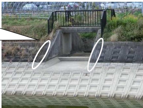
洪水吐(貯水池側より)
