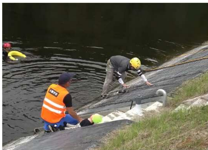
法面にネットの設置
