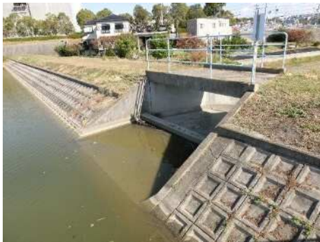
洪水吐(上流側)
