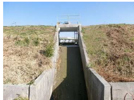
洪水吐(下流側)
