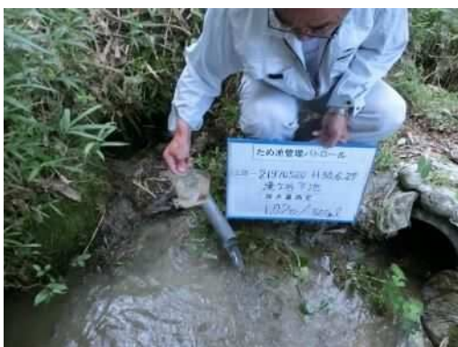
後法 漏水量測定(遠景)
