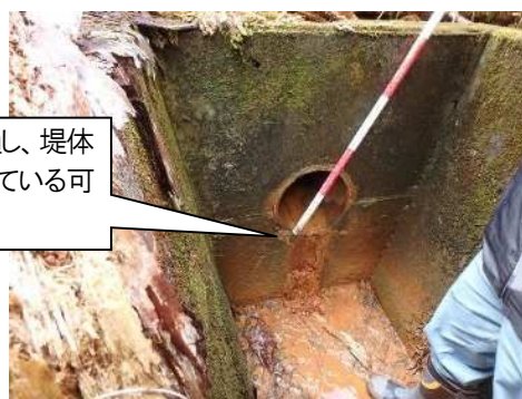
底樋出口(堤体下流)
