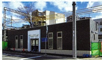
新設された大池駅下り駅舎
