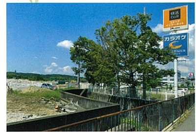
解体工事中の光景
