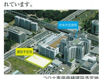
コロナ専用病棟建設予定地
