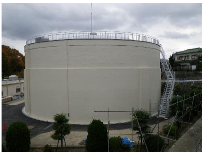
(鈴蘭台配水池)
