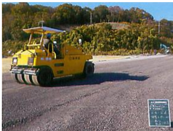
下層路盤工の施工状況
