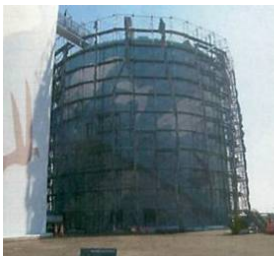
外面足場の施工状況
