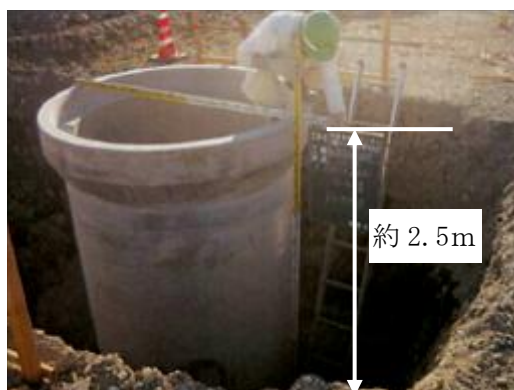
基礎工の高さ測定状況
