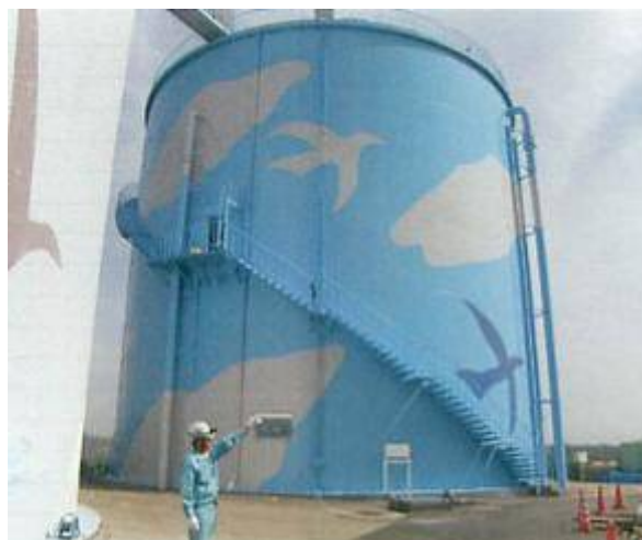
1 号池 完成状況
