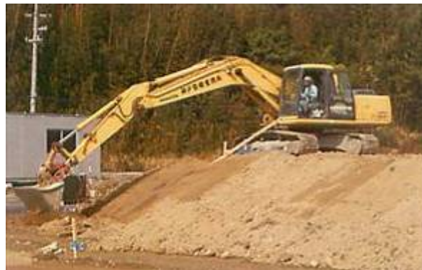
盛土法面整形の施工状況（削り取り整形）
