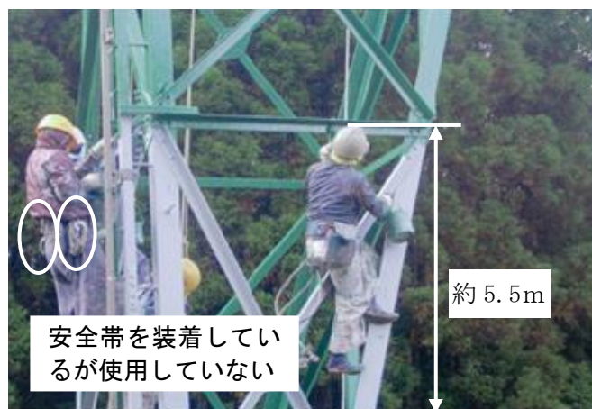
支柱塗装状況
