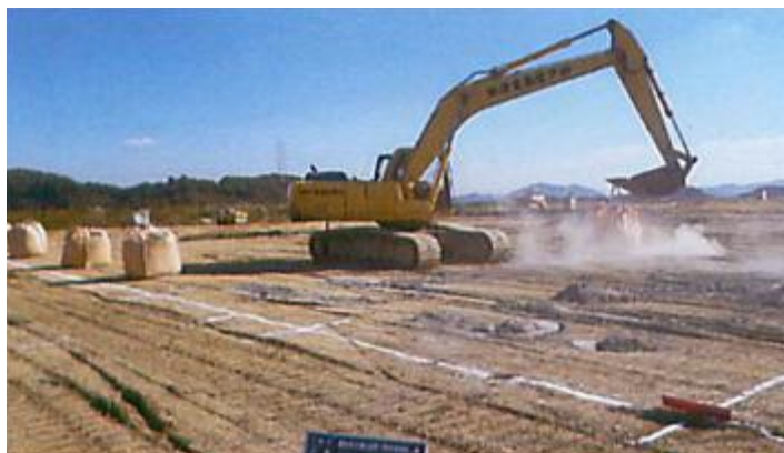
固化材混合の施工状況
