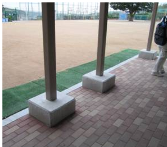
コンクリート基礎
