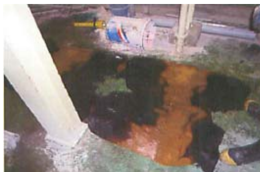
防災シートの状況
