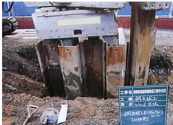
鋼矢板の建込み状況
