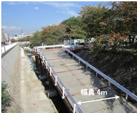
仮栈橋の状況
