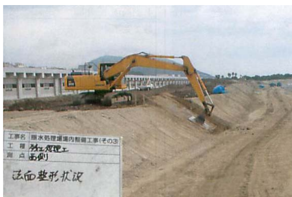
盛土法面整形の状況
