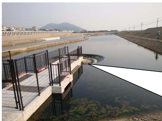
修景池と排水口
