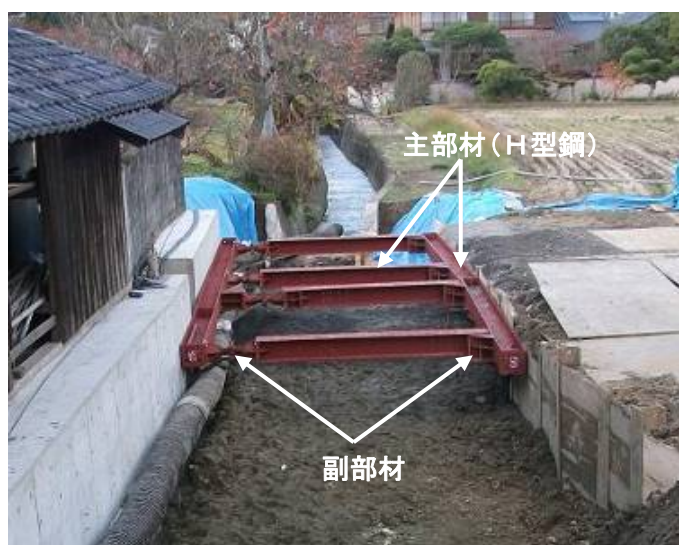
仮設土留めの状況
