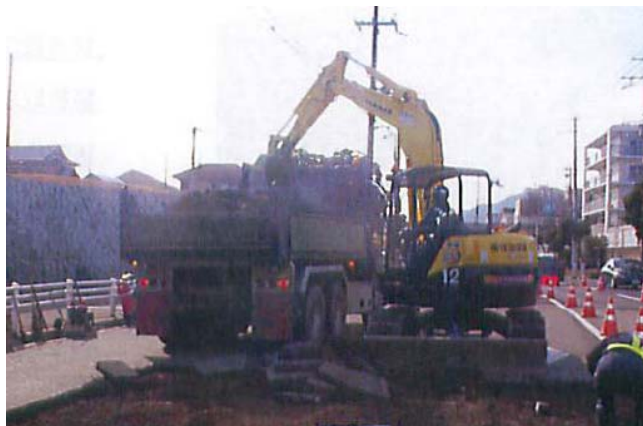
アスファルト殻の積込み状況
