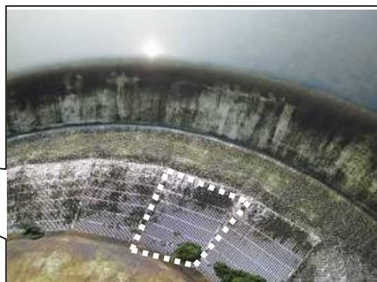
排水口のステンレス製グレーチング蓋 （サイズ 766×691×20 mm, 18 枚）
