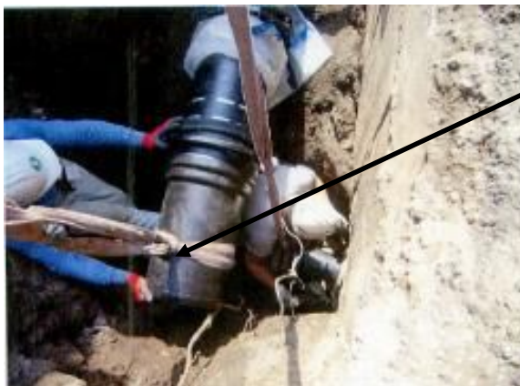
吊った状態の水道管
