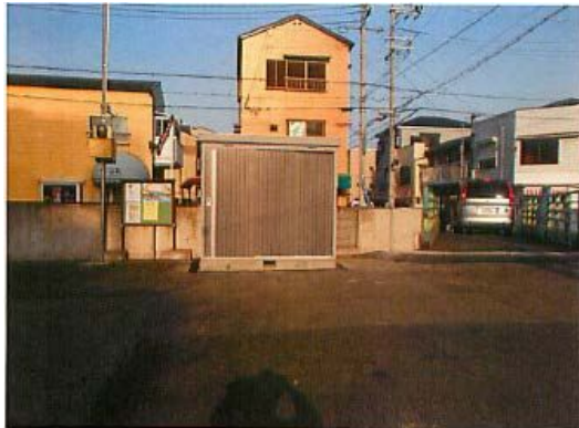
角落し収納倉庫設置状況
