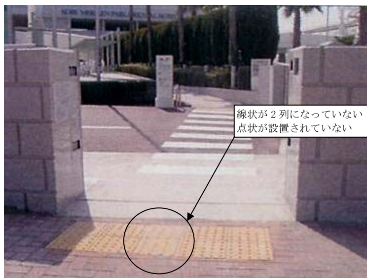
本工事の設置状況
