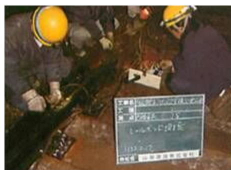
レールボンド線復旧
