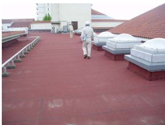
温泉健康センター屋上
