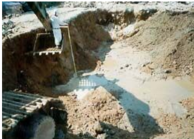
パワー・ショベルのバケットに乗って作業している状況
