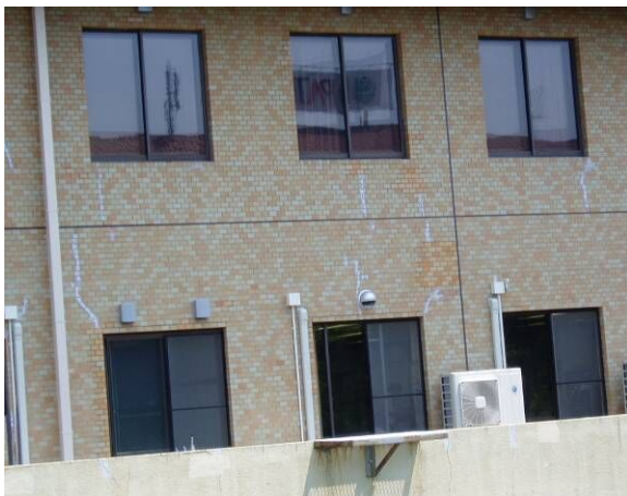
壁面補修の跡
