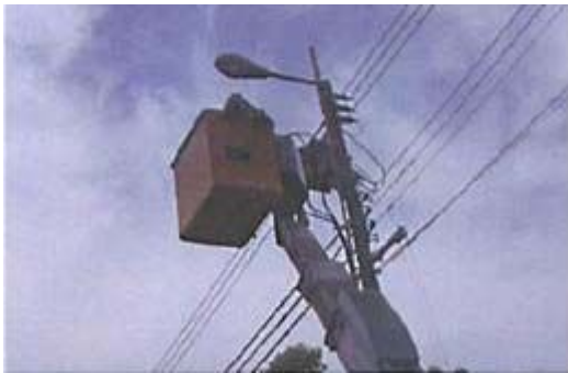
高所作業による球換え作業中
