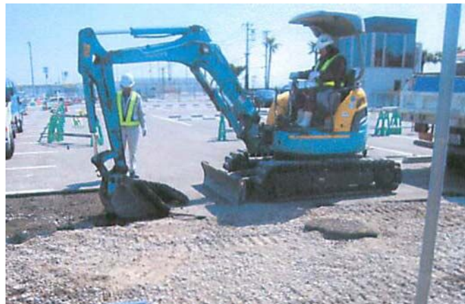
機械施工の状況
