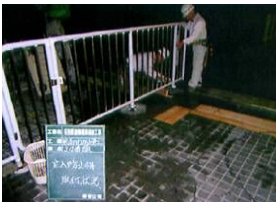
軌道内立入禁止柵設置工
