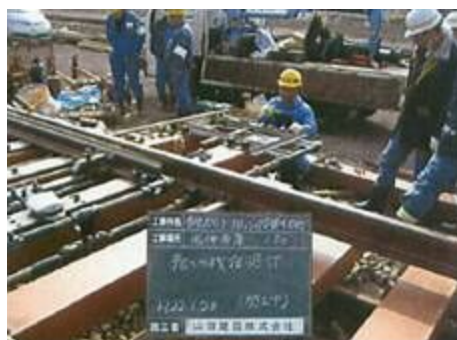
転てつ機据付
