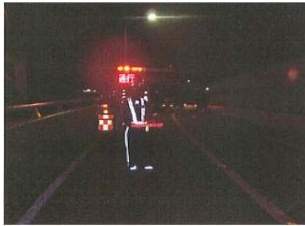
点検業務状況（夜間道路規制中）
