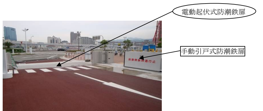
防潮鉄扉の全景
