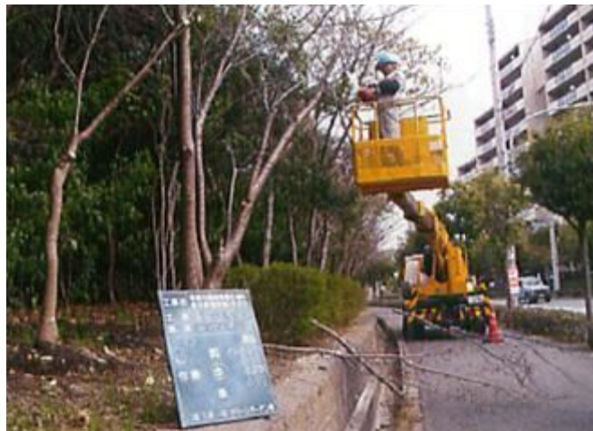
歩道へ車両を乗り入れている状況
