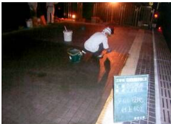
プラットホーム復旧工
