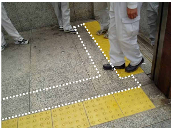
点字ブロックが 1 列しか設置されていない (正しくは 2 列設置)
