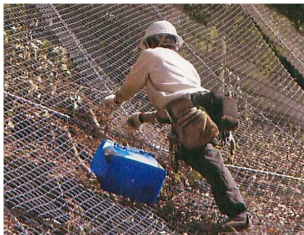
急傾斜の高所作業で安全帯を使っていない
