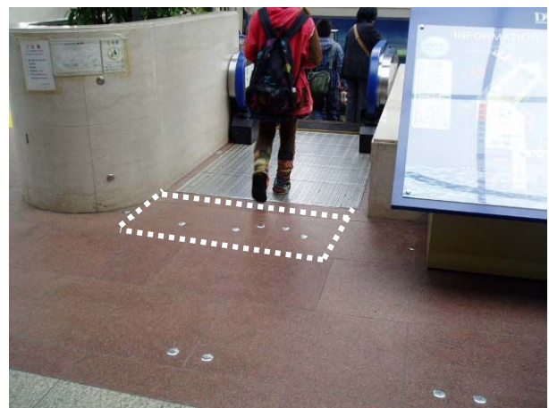
エスカレーター前に点字ブロックが設置されて いない
