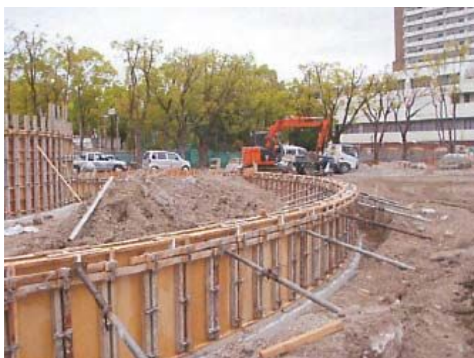
型枠設置状況（ウォール工－3）
