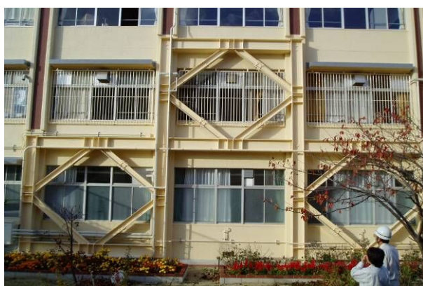
「神戸市型枠付き鉄骨ブレース直付け耐震補強工法」(3構面で1組)
