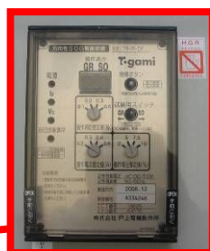
地絡保護装置(受変電設備内にあり)
