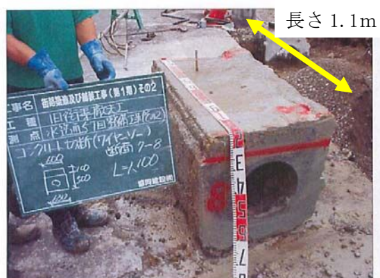
カットした街渠
