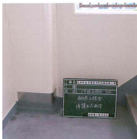
ケーブルラックカバー取付完了
