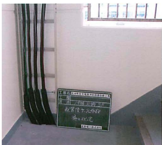
ケーブル布設工事中
