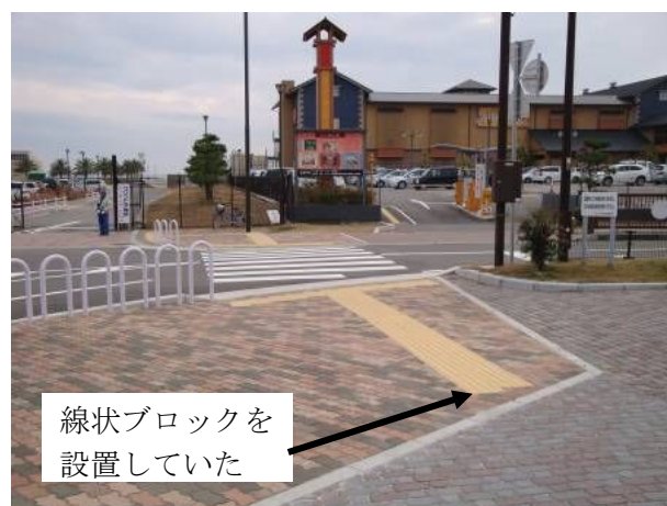
本工事の設置状況
