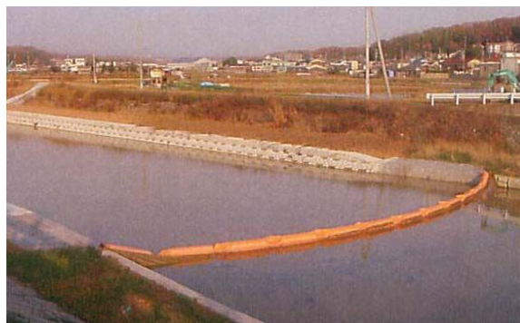
汚濁防止フェンス
