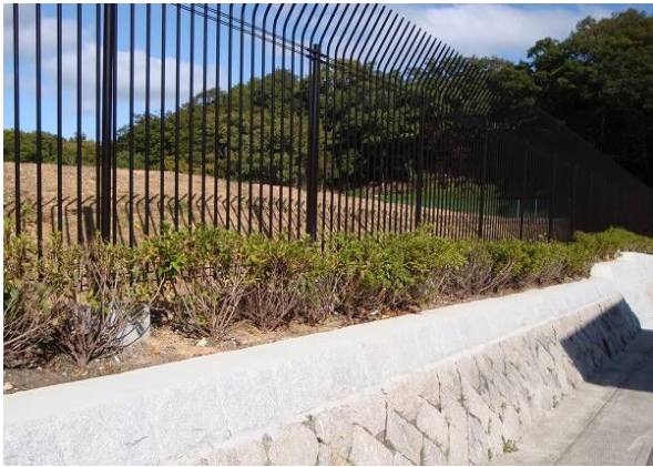
格子フェンスの設置状況
