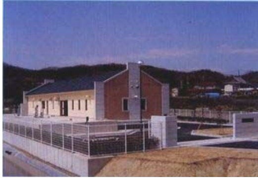
中山・野瀬地区農業集落排水処理施設
