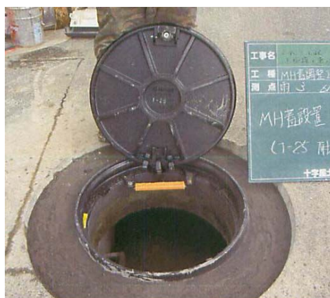
マンホール蓋替えの状況
