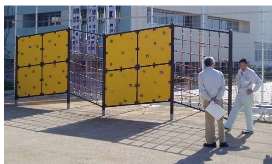
四連クライミングの設置状況
