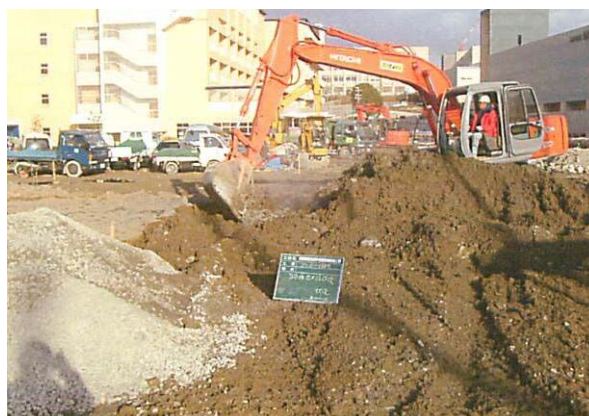
セメント安定処理の状況
