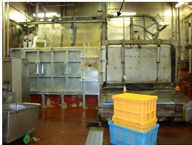
と畜解体処理設備
