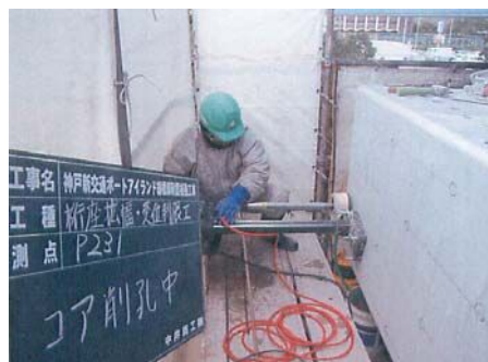
桁座拡幅（削孔）
