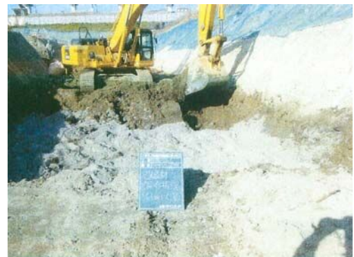
地盤改良状況
