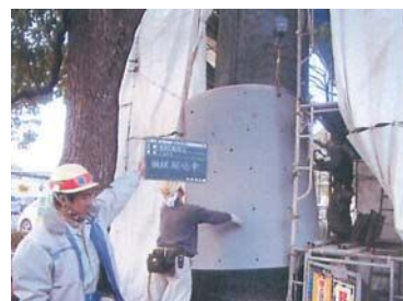
鋼板巻きつけ（ t=12\text{mm} ）
