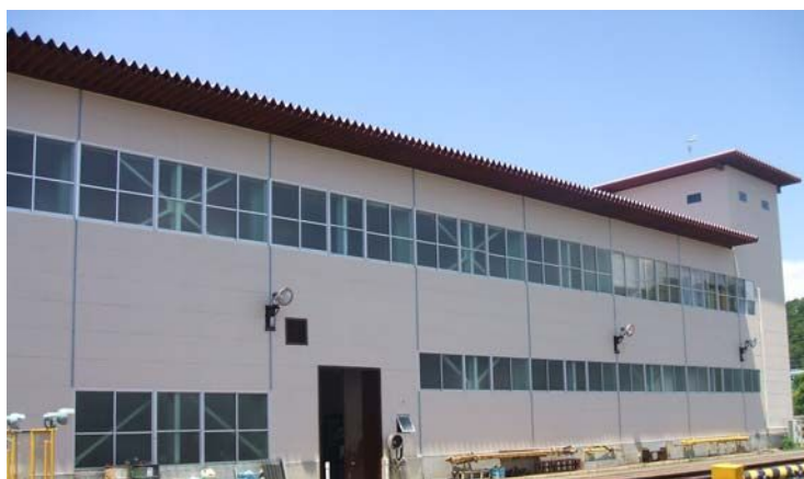
保線作業所(外壁面を塗装改修)
