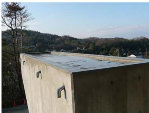
橋脚等の天端の周囲（嵩上げされている）
