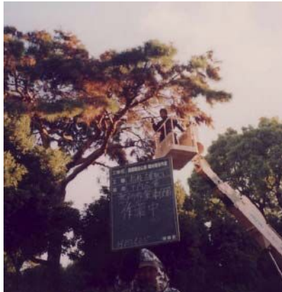
高所作業車による高木剪定
