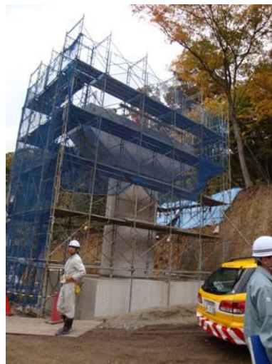
建設中の橋脚
