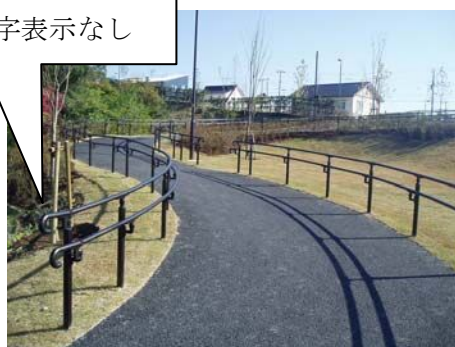
傾斜路の手すりに点字表示なし
