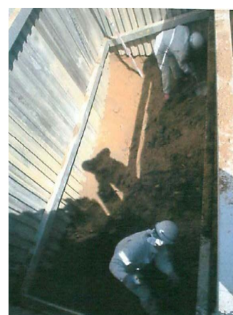
その後の土留め
