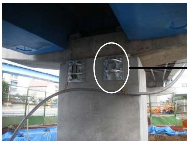
設置後のブラケットプレート（補強済）
