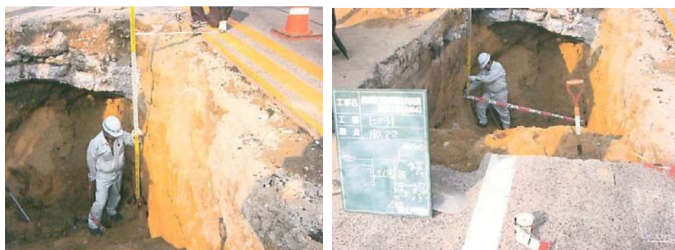
土留工のない試掘（掘削深約 3 m）
