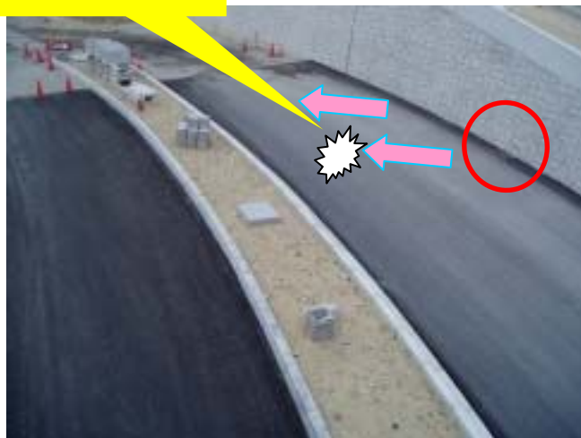
西側擁壁遠景
