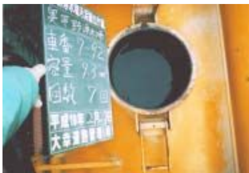
バキューム車の満タン検収写真
