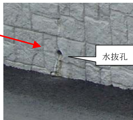
水抜孔付近拡大写真
