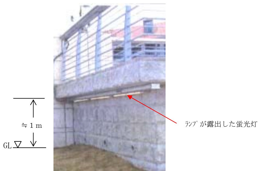
緑地 張り出しデッキ下部の照明（蛍光灯）の取付状況
