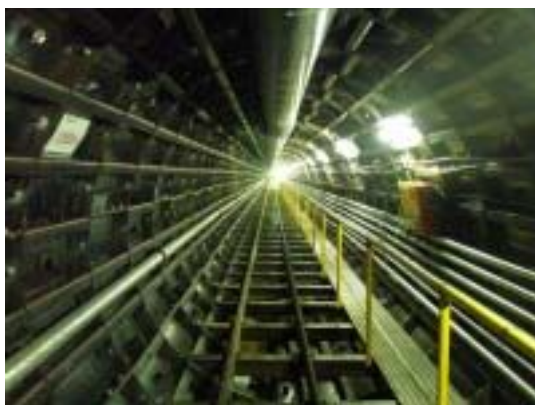
シールド 1 次覆工の状況
