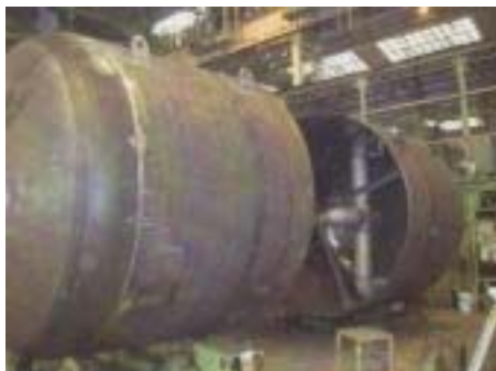
鋼製貯水槽の工場製作状況
