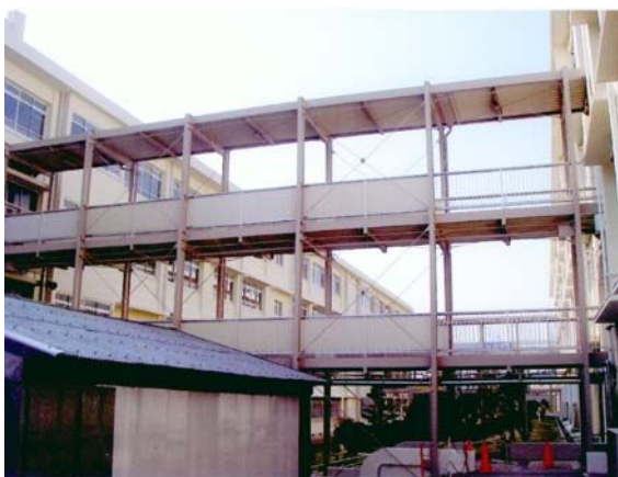
屋外渡り廊下
