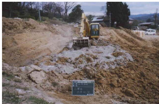
セメント混合処理の状況
