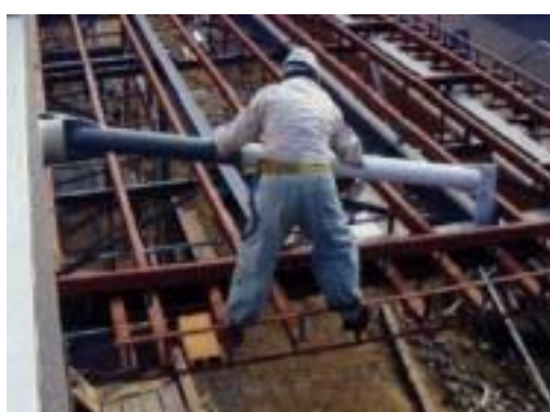
展示場の塗装作業
