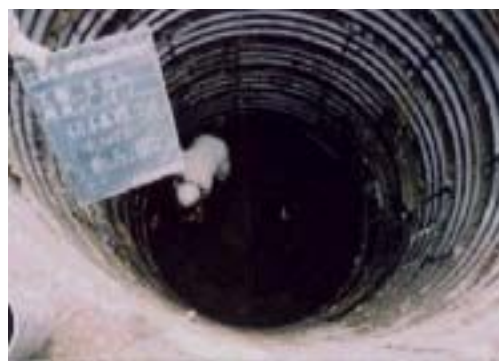
僧尾地区管路施設工事（その4）
