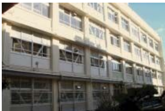
舞子中学校の耐震補強状況
