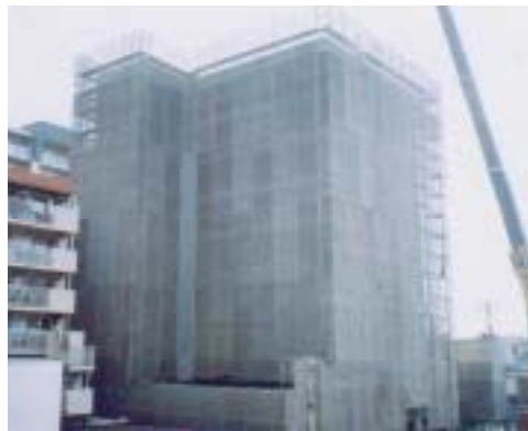
足場及び養生シートの設置状況
