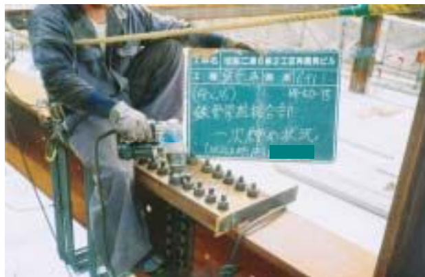
高力ボルト締付け作業
