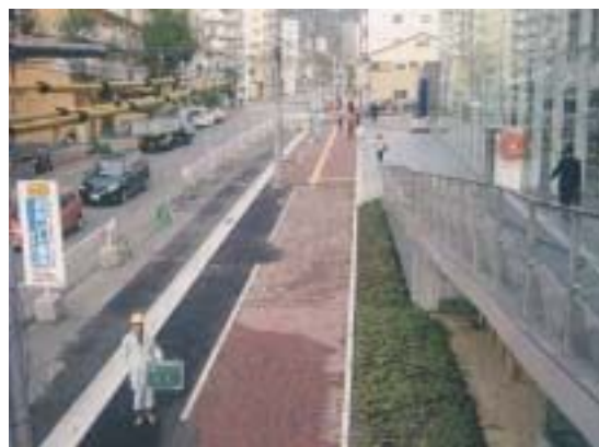
完成時のインターロッキング舗装
