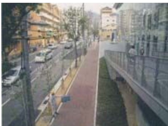
着手前のインターロッキング舗装
