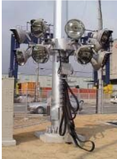
昇降式照明塔 (器具を降ろした状態)
