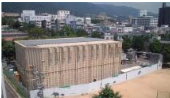
防音ハウスの全景
