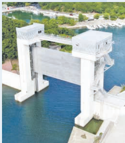
県内初の津波対策専用河川水門である南あわじ市の本庄川水門。
