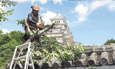
姫路城の壁面修復工事に先立ち、作業を阻害する枝を慎重に見極めながら伐採する堀さん。
