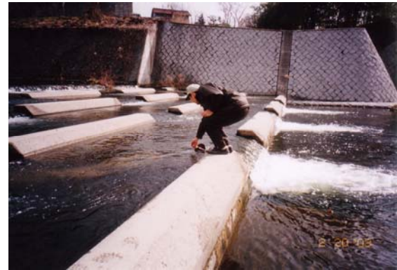
内分泌攪乱化学物質調査（志染川・坂本橋）
