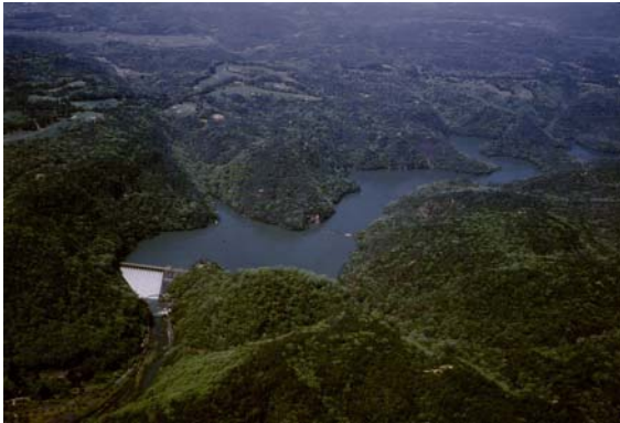
千苧水源池・取水塔前（公共用水域 No. 3）
